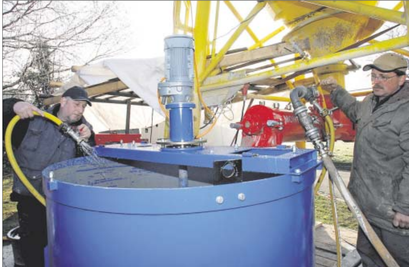
Uwe Gergoskis (l.) und Andreas Mazyrk stellen den Spezialbeton vor Ort her.
